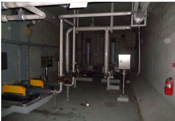
내부 지하2층 송풍기실 전경
