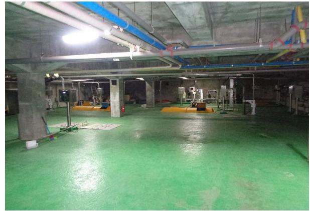
내부 지하1층 전경
